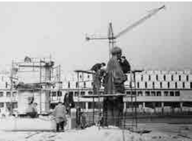
Budowa pomnika Marii Skłodowskiej-Curie. W tle budowa Biblioteki Międzyuczelnianej
